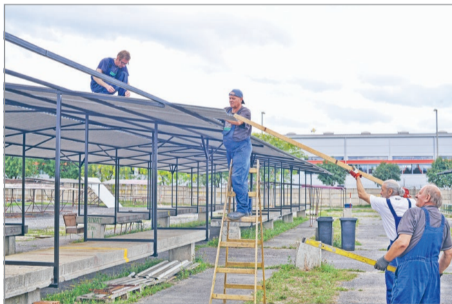
A vásárlókat, a kereskedőket és a portékákat is védi majd az új tető. Fotó: Osztie Tibor
