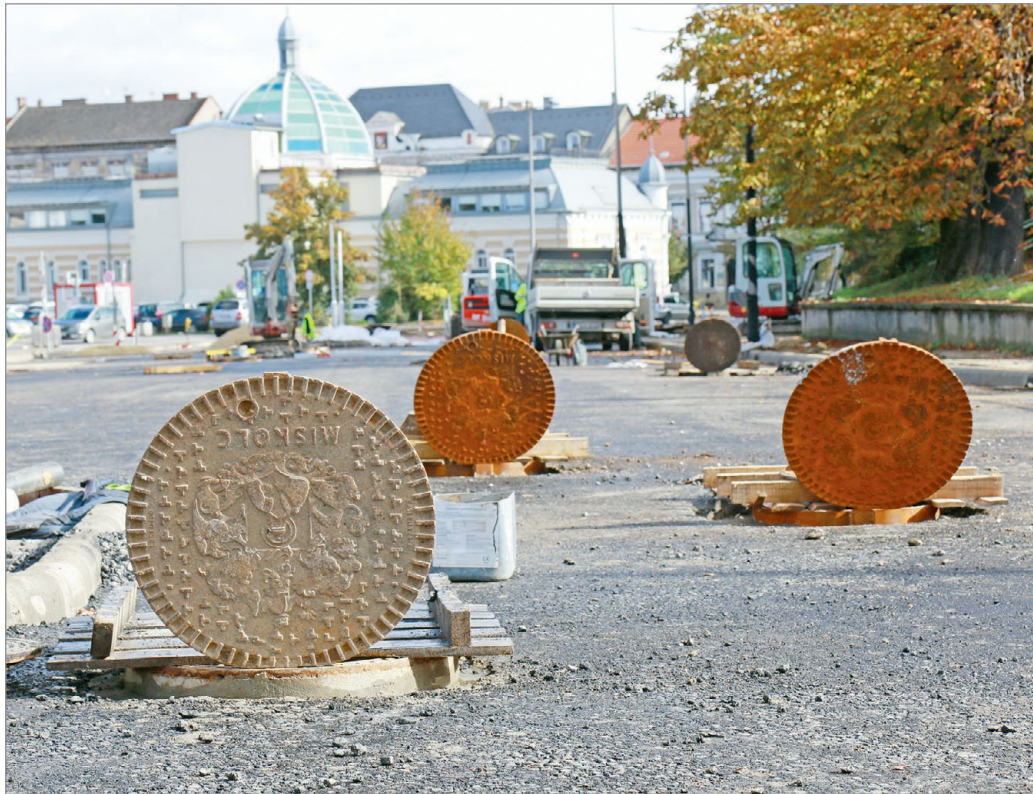
Végéhez közeledik a Dayka-átkötés kialakítása, és a hozzá kapcsolódó utak átépítése. Fotó: J. Á.
