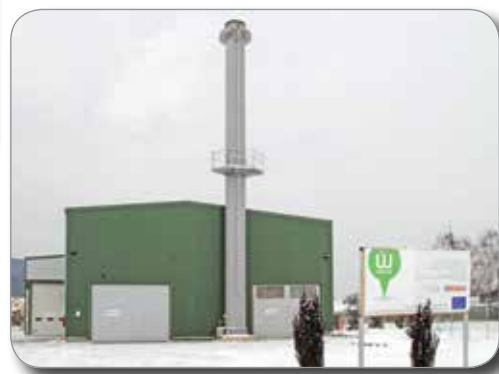
A Kiliáni lakótelep hőellátását biztosító, faapríték-tüzelésű fűtőmű.
