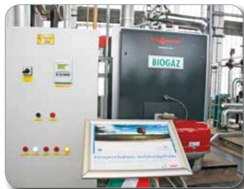
Biogáz eltüzelésére alkalmas kazán.
