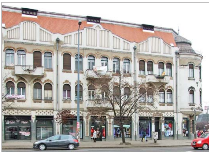
Az északi homlokzat megkopott a felújítás óta.
