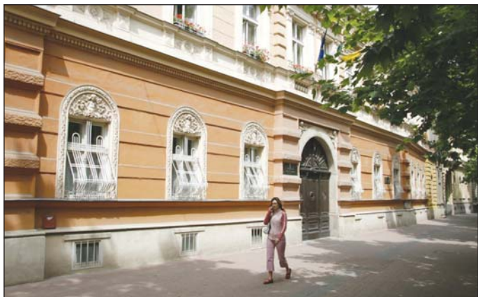
A Fráter György katolikus iskola épületének főhomlokzata.
