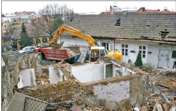
A melléképületek bontásával kezdődött el a beruházás.
